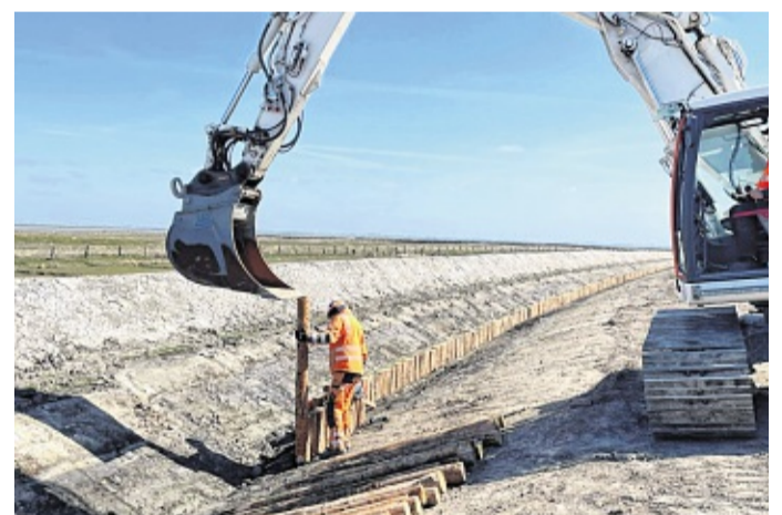
Über 23000 solcher Holzpfähle werden auf der 3200 Meter langen Strecke verbaut.
